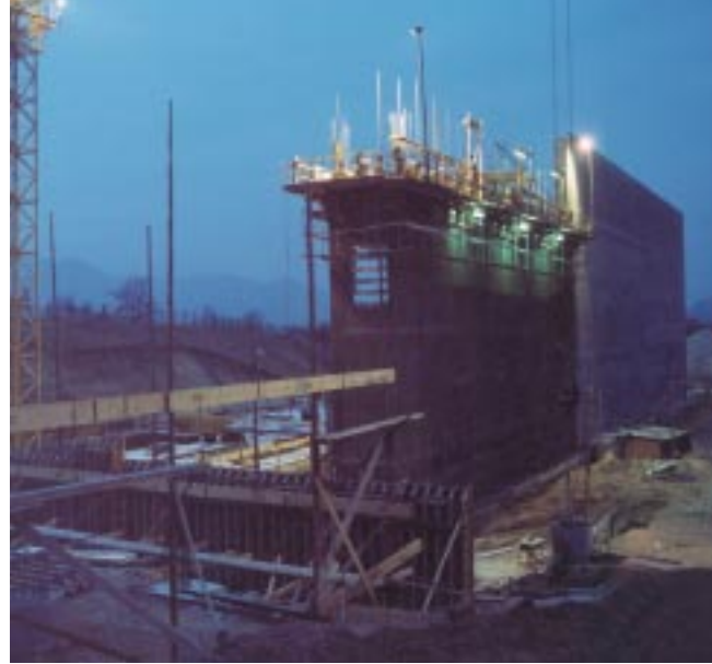
In mehreren Bauabschnitten entstand zwischen 1975 und 1981 ein modernes Warenverteilszentrum.
