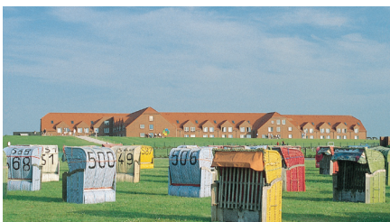
Es dauerte lange Zeit, bis auf dem Gelände hinter dem Deich die heutige Klinik Norddeich entstehen konnte
